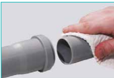
۳ لوله و اتصال را بوسیله یک دستمال تمیز پاک کنید.
